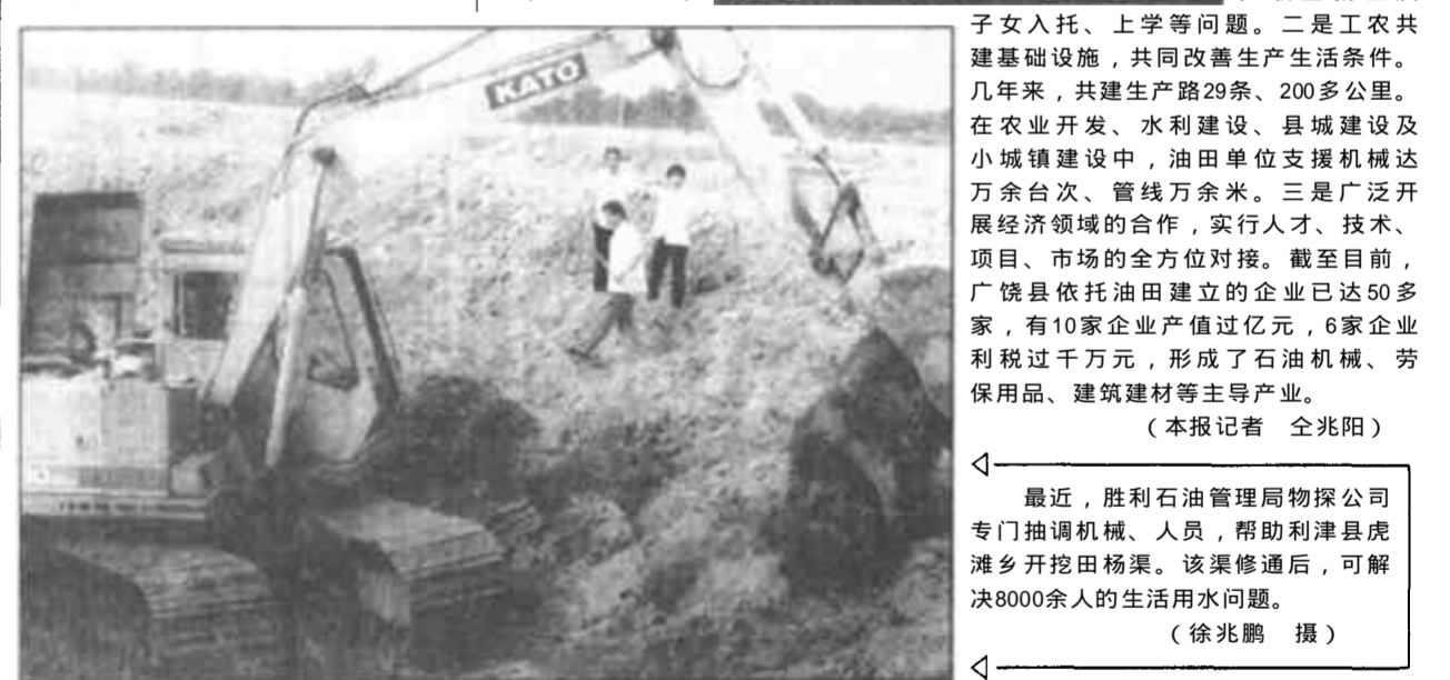
最近,胜利石油管理局物探公司专门抽调机械、人员,帮助利津县虎滩乡开挖杨渠。该渠贯通后,可解决8000余人的生活用水问题。(徐兆鹏 摄)
